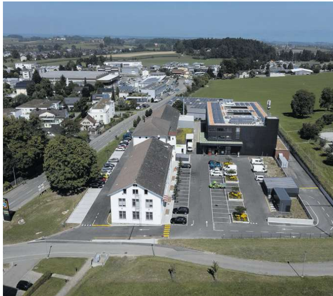
Der ehemals blaue Gewerbebau wurde komplett saniert und hat nun eine schwarze Fassade (rechts). Im Erdgeschoss ist Aldi eingezogen. Der angrenzende weisse Kopfbau entlang der Arbonerstrasse soll der-einst ebenfalls renoviert werden. Bild: Benjamin Manser
